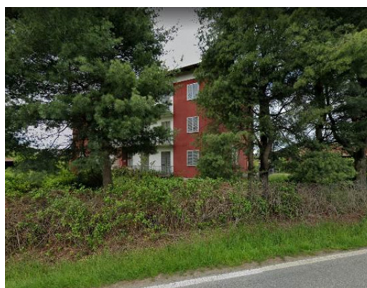
Ric1 – Edificio residenziale
