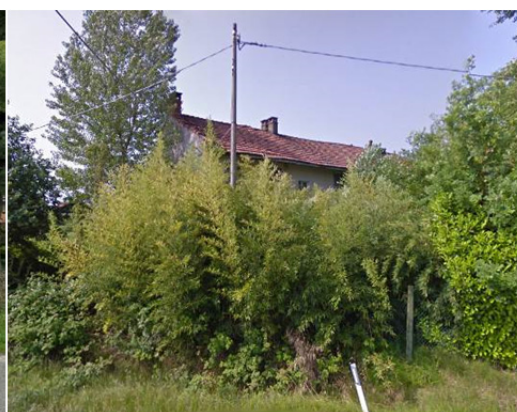
Ric2 – Edificio residenziale
