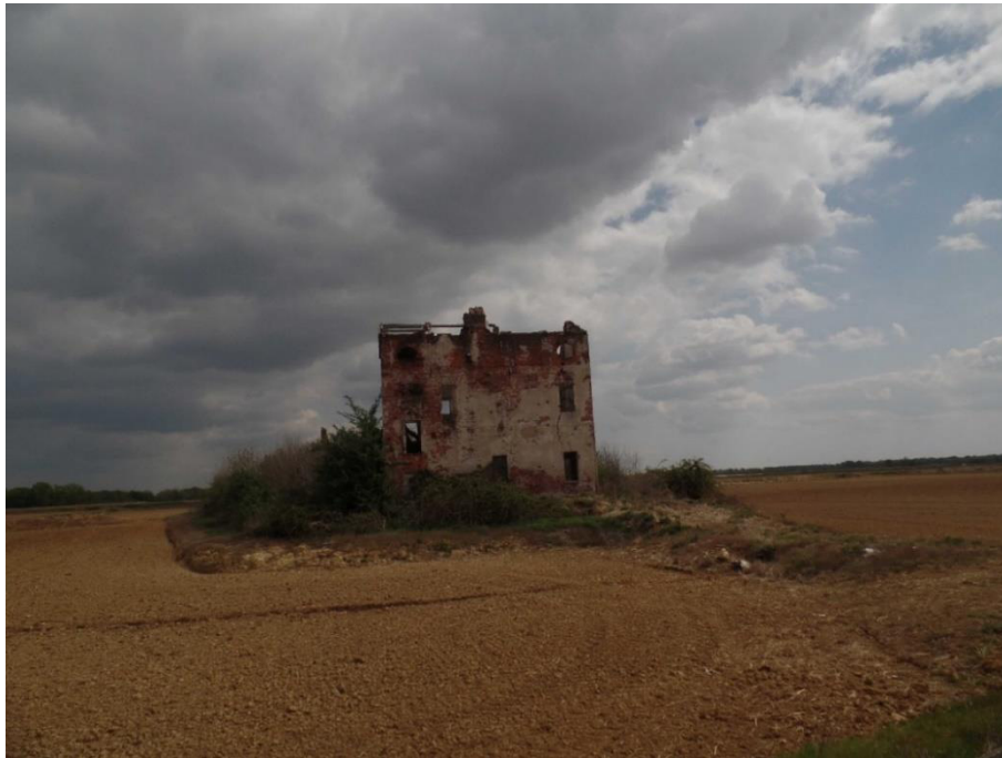
Figura 21: Visuale dell'edificio parzialmente diroccato situato nel settore centro-occidentale dell'area di intervento
