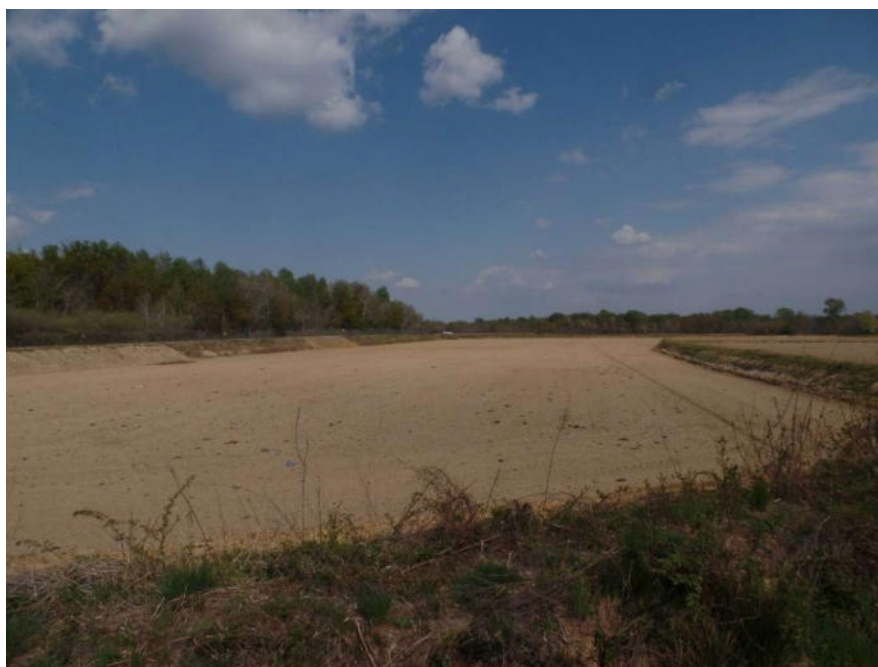
Foto 3: Panoramica del settore sud-est dell'impianto.
