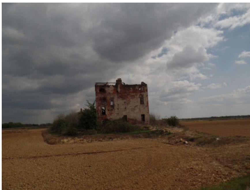
Figura 18: Visuale dell'edificio parzialmente diroccato situato nel settore centro-occidentale dell'area di intervento.
