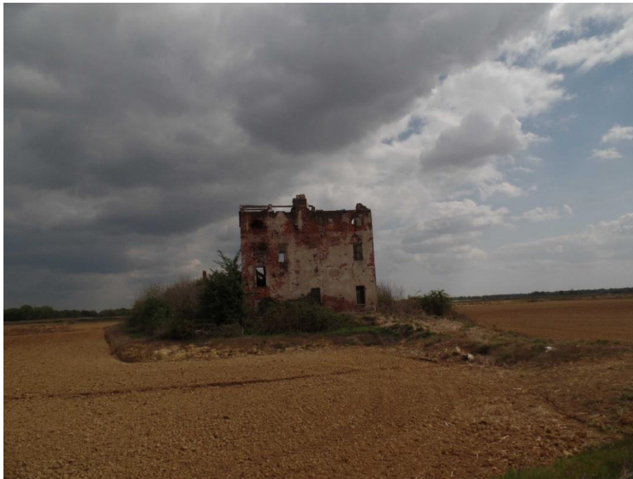
Figura 25: Visuale dell'edificio parzialmente diroccato situato nel settore centro-occidentale dell'area di intervento.
