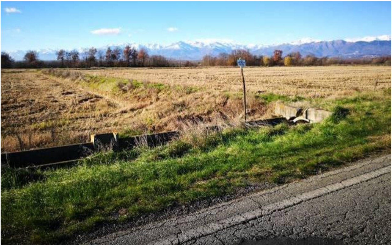
Foto 6: Vista da E (mezzeria) verso O
