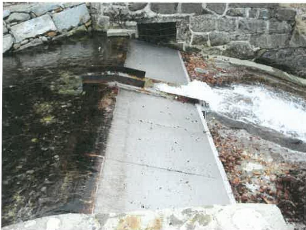
Fig. 1 - Opera di presa sul torrente Oropa con – al centro – il dispositivo per il rilascio del D.M.V.
