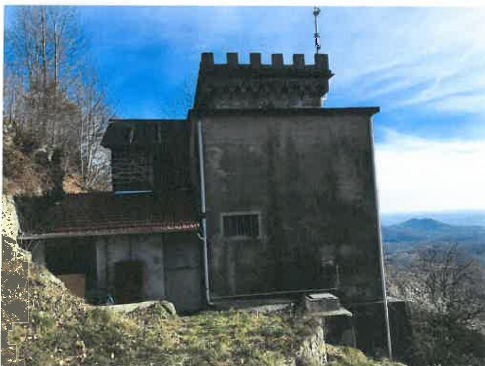
Fig. 6 – Il fabbricato che ospita la vasca di carico dell'impianto, da cui partono le condotte forzate
