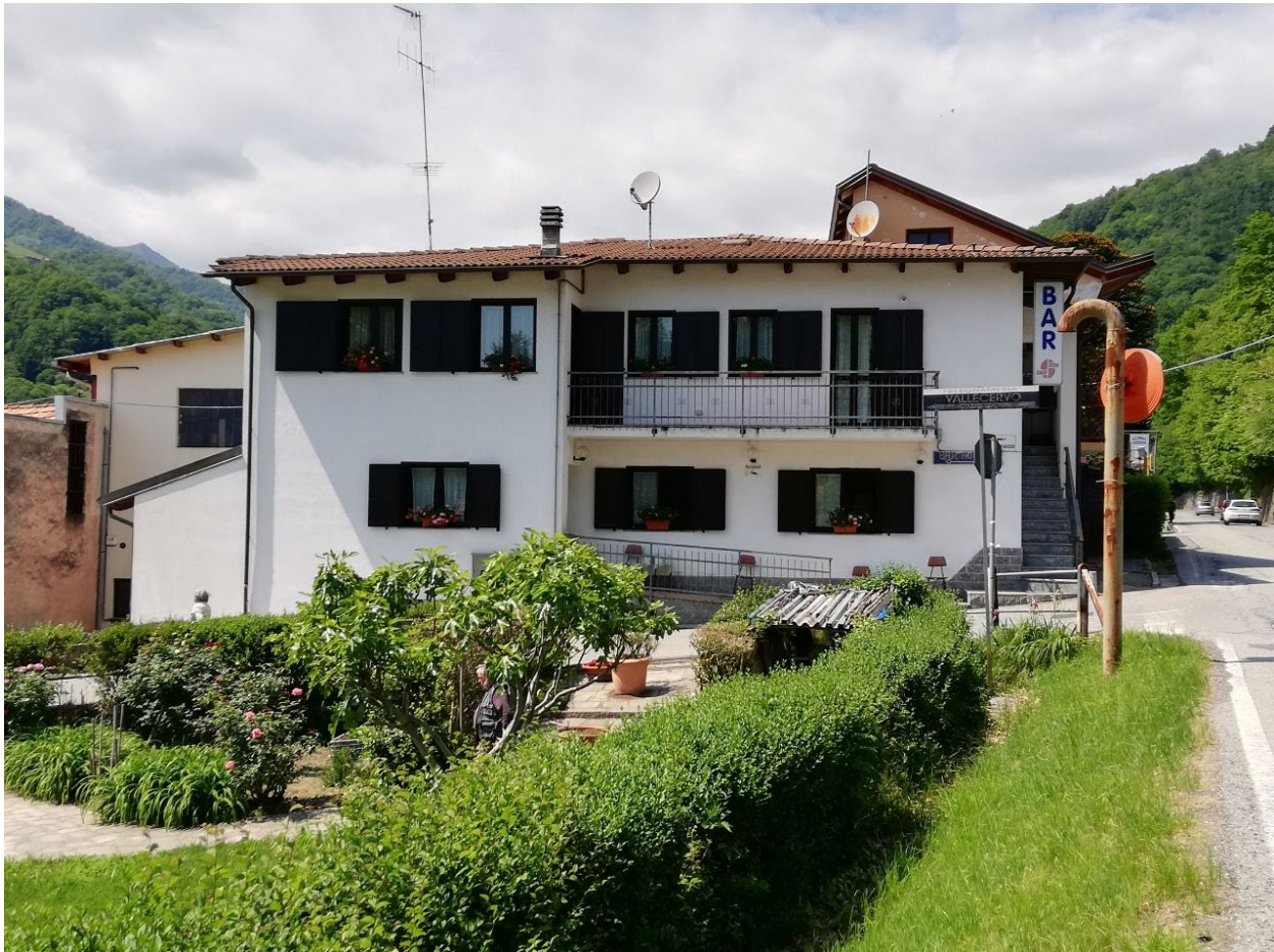
Figura 24: Foto ricettore 17 - Sopralluogo 31/05/2021.
