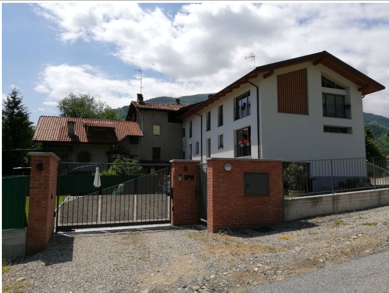
Figura 19: Foto ricettore 12 - Sopralluogo 31/05/2021.
