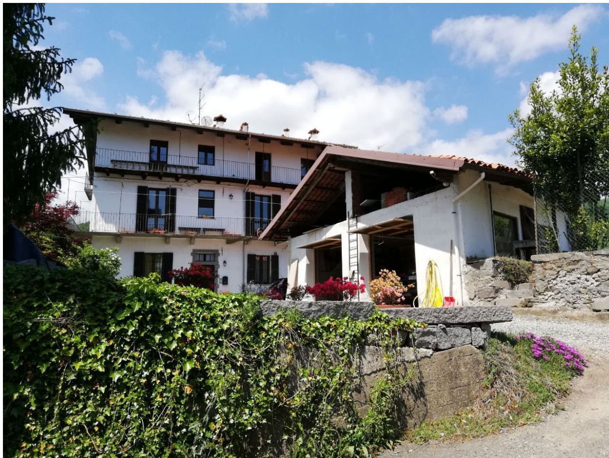
Figura 20: Foto ricettore 13 - Sopralluogo 31/05/2021.
