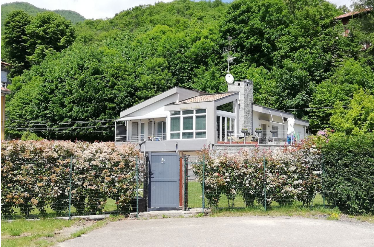
Figura 18: Foto ricettore 11 - Sopralluogo 31/05/2021.
