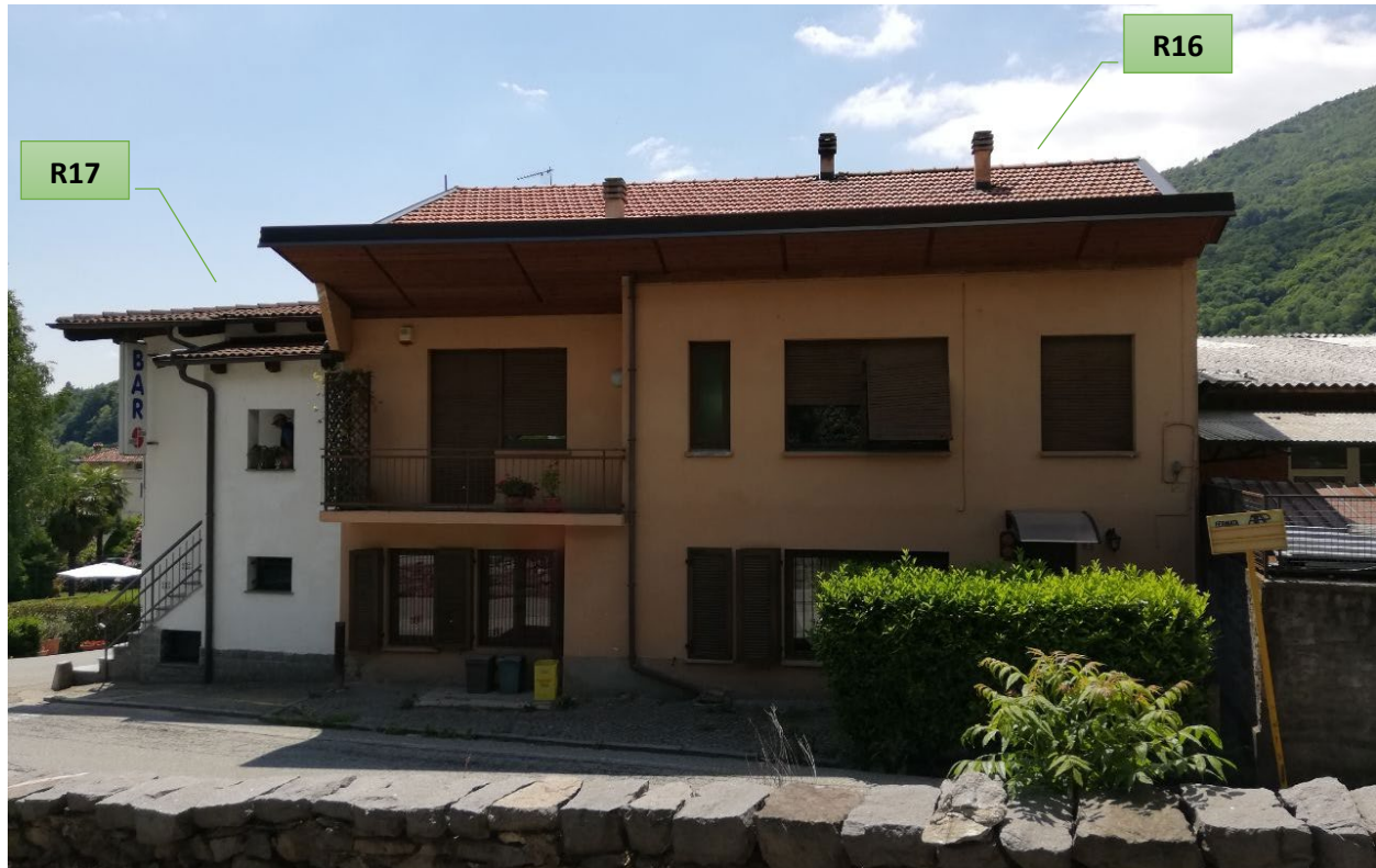
Figura 23: Foto ricettore 16 - Sopralluogo 31/05/2021.
