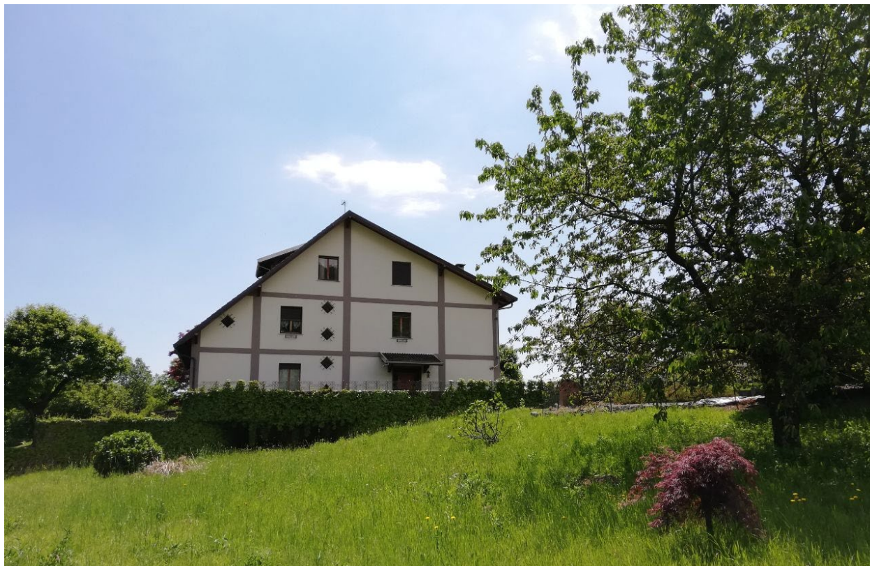
Figura 21: Foto ricettore 14 - Sopralluogo 31/05/2021.
