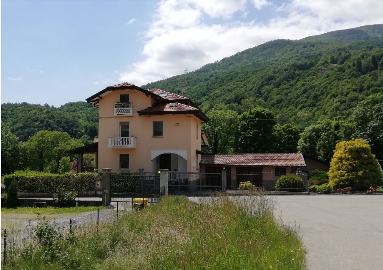
Figura 14: Foto ricettore 5 - Sopralluogo 31/05/2021.
