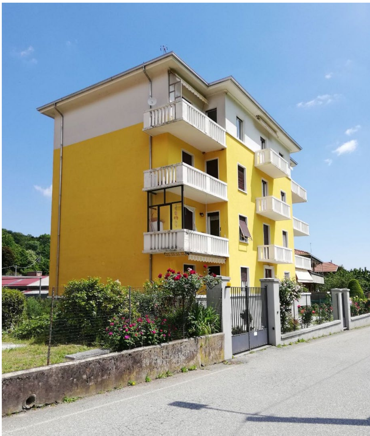
Figura 12: Foto ricettore 3 - Sopralluogo 31/05/2021.
