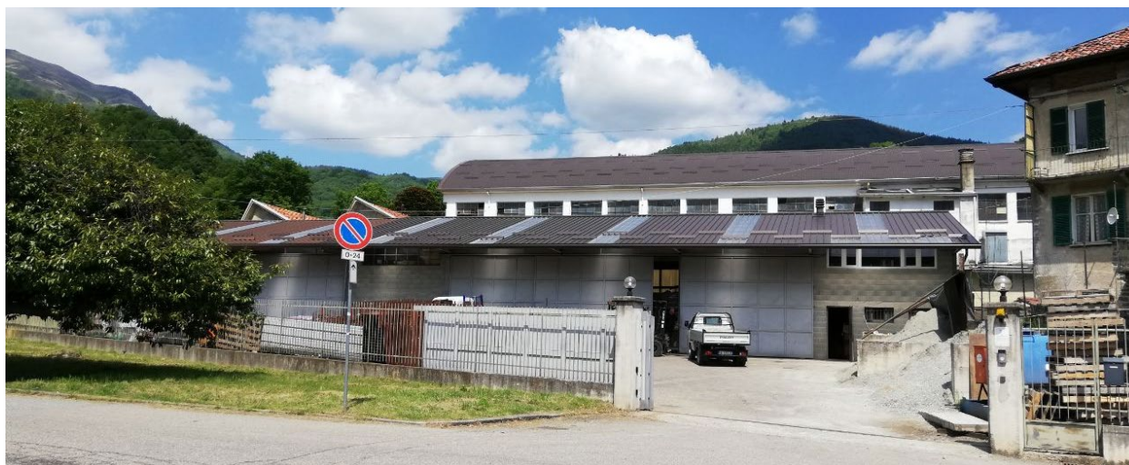
Figura 22: Foto ricettore 15 - Sopralluogo 31/05/2021.
