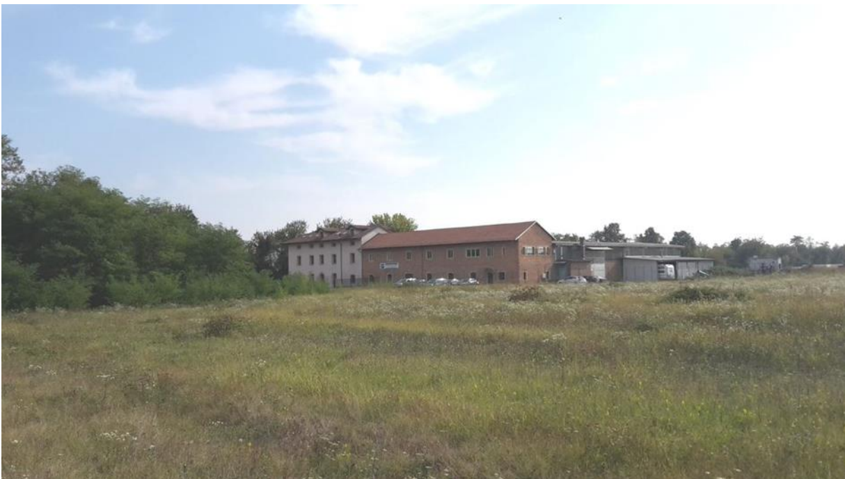
Fig. 24 – Area di intervento destinata al nuovo impianto di produzione
