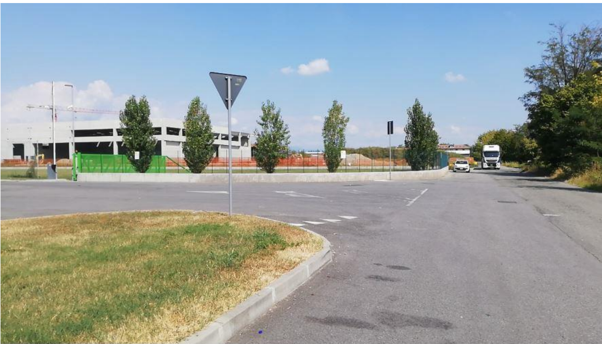
Fig.26 - Strada della Mandria in prossimità dell'ingresso dell'impianto plastiche
