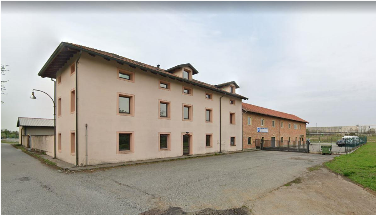
Fig.23 - Cascina esistente da demolire
