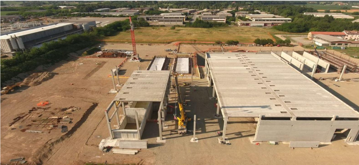
Fig.25 - Impianto in fase di costruzione
