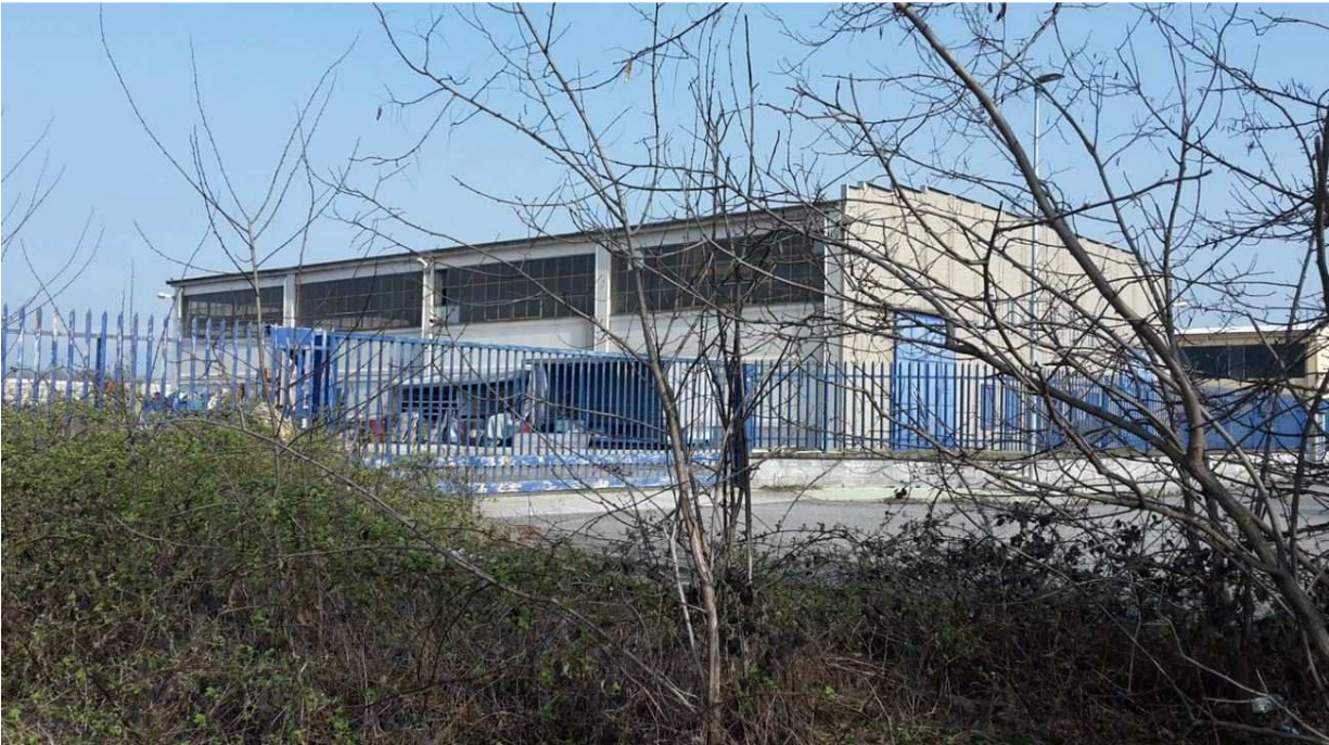
Foto 10: Area di proprietà presso il confine nord; nell'immagine è visibile la recinzione (di colore blu) e relativi fabbricati industriali di proprietà di Terzi; è inoltre visibile la strada asfaltata parallela alla Strada della Mandria
