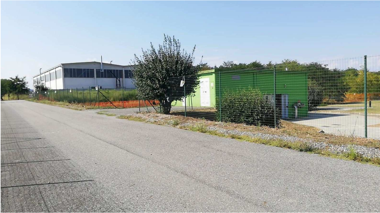
Foto 30: Strada asfaltata privata tra impianto TMB (a destra) e discarica (a sinistra); sullo sfondo nell'immagine sono visibili i fabbricati industriali di proprietà di Terzi (di colore chiaro). Al centro è inoltre visibile la recinzione di cantiere relativa alle connessioni dell'impianto FORSU in fase di realizzazione
