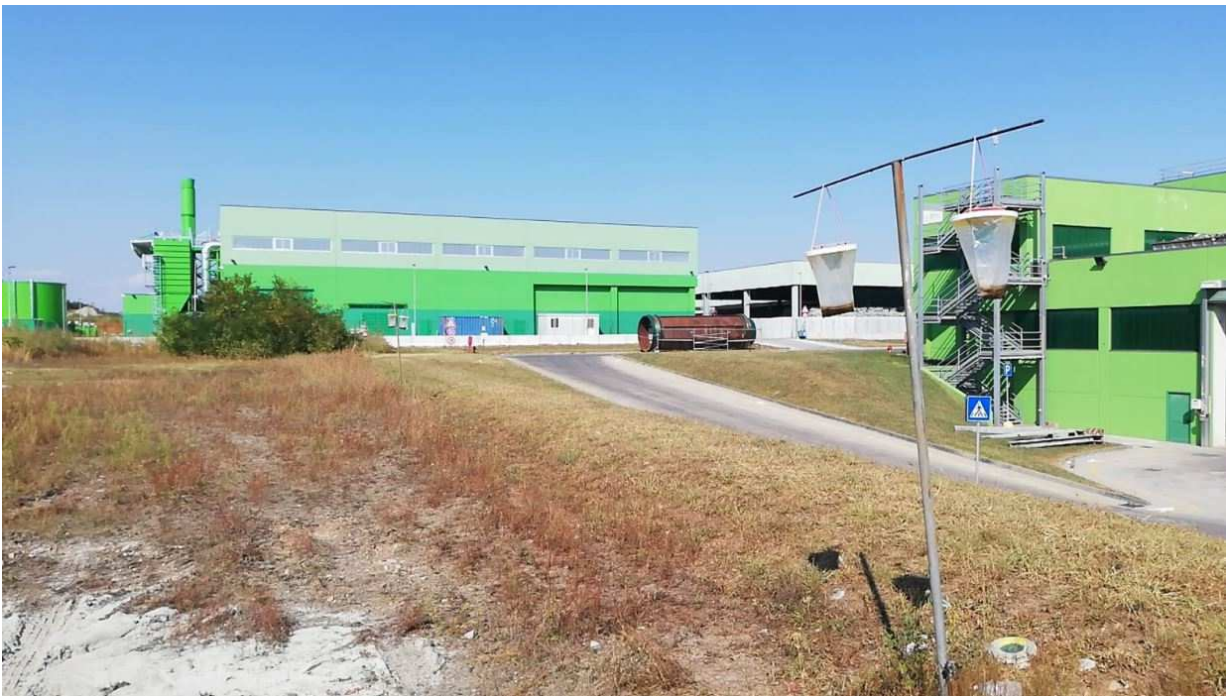
Foto 35: Vista da impianto TMB verso impianto plastiche ed impianto FORSU in fase di realizzazione
