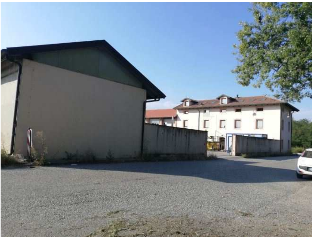
Foto 13: Strada della Mandria, cascina destinata alla demolizione
