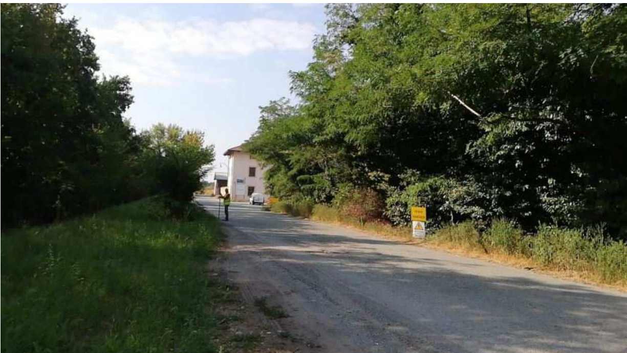
Foto 11: Strada della Mandria che corre lungo il confine est dell'area di proprietà, sulla destra dell'immagine è visibile l'area occupata dallo scolmatore, al centro la cascina destinata alla demolizione, sulla sinistra la vegetazione che corre lungo l'argine del Naviglio il Navilotto
