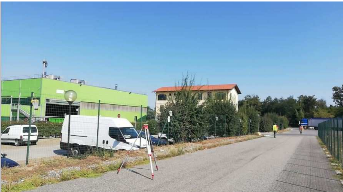
Foto 29: Strada asfaltata privata presente tra impianto TMB (a sinistra) e discarica (a destra nell'immagine). A sinistra nell'immagine sono visibili in particolare la palazzina uffici, il parcheggio interno e l'impianto TMB.
