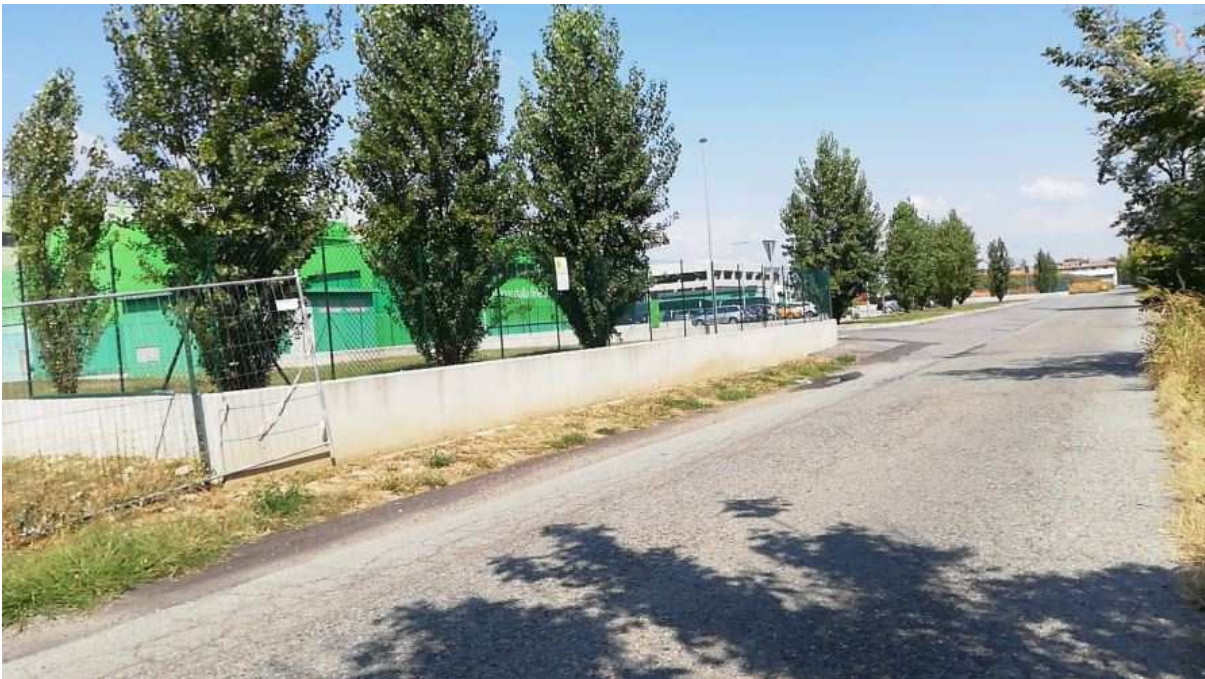
Foto 23: Strada della Mandria, vista dell'impianto plastiche, sullo sfondo dell'immagine sono visibili l'area di cantiere dell'impianto FORSU in fase di costruzione e la cascina destinata alla demolizione
