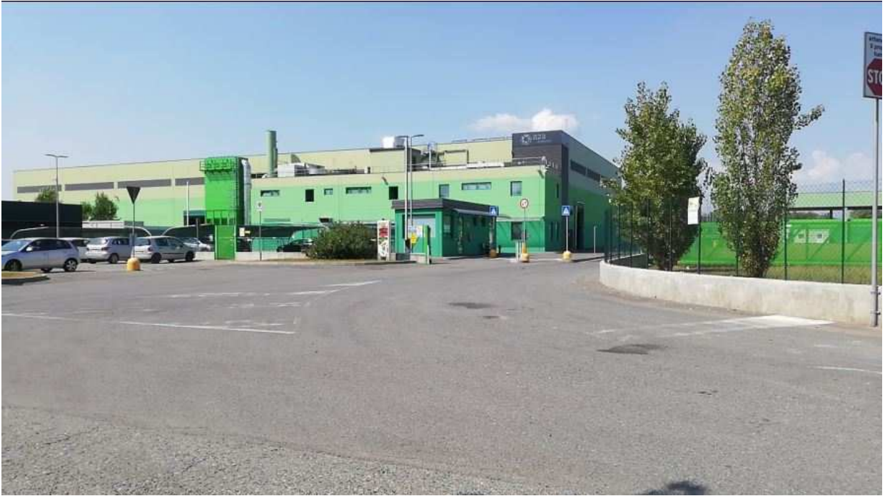
Foto 20: Strada della Mandria, ingresso all'impianto plastiche
