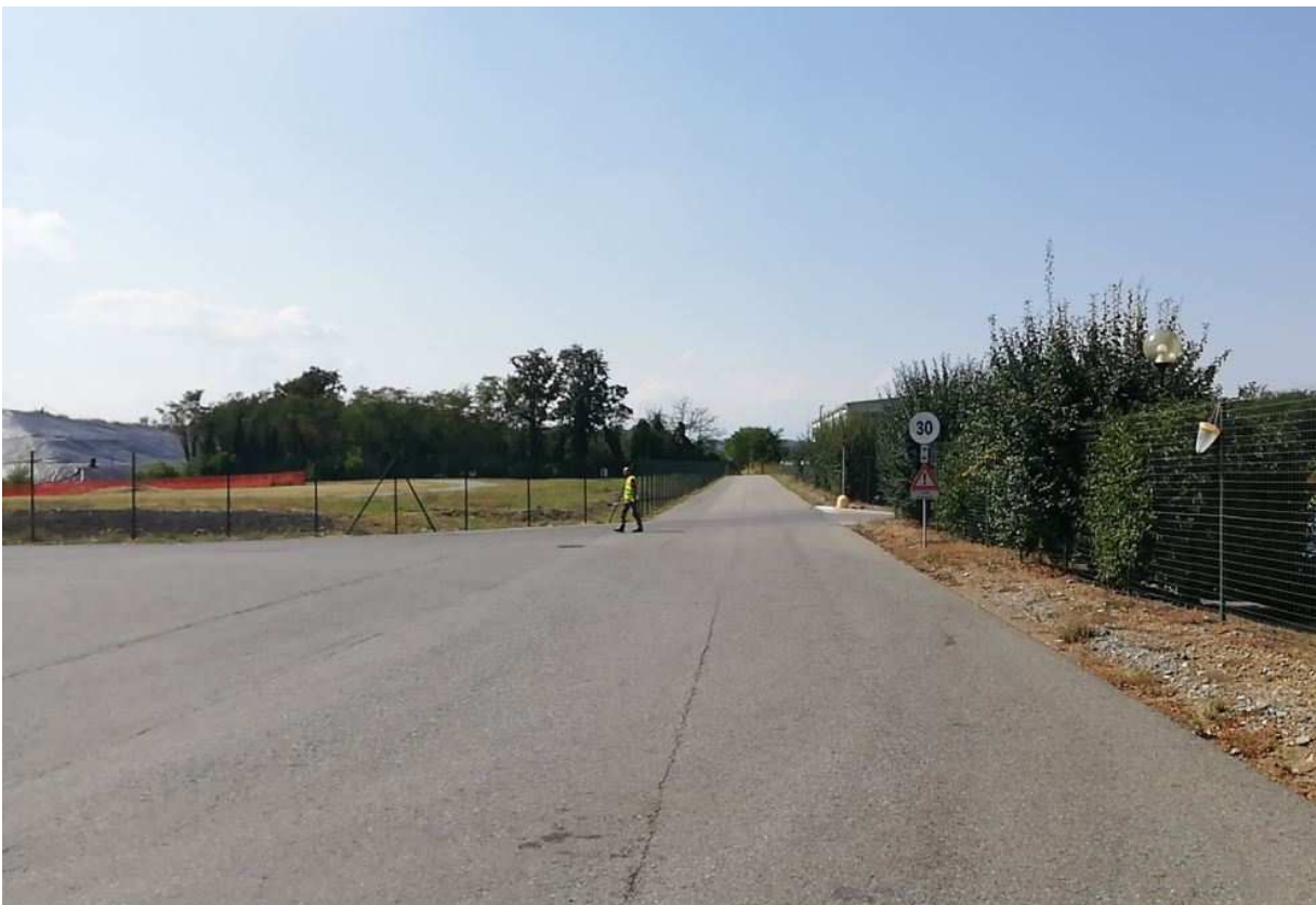
Foto 27: Impianto TMB, strada asfaltata privata tra impianto TMB (a destra) e discarica (a sinistra)
