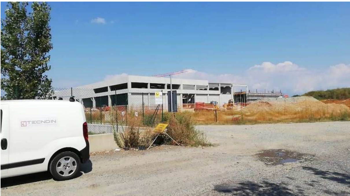
Foto 17: Strada della Mandria che corre lungo il confine est dell'area di proprietà; nell'immagine è visibile la recinzione dell'area di cantiere dell'impianto FORSU attualmente in fase di costruzione
