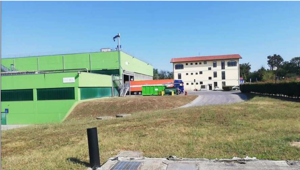
Foto 34: Vista dell'impianto TMB e relativa palazzina uffici
