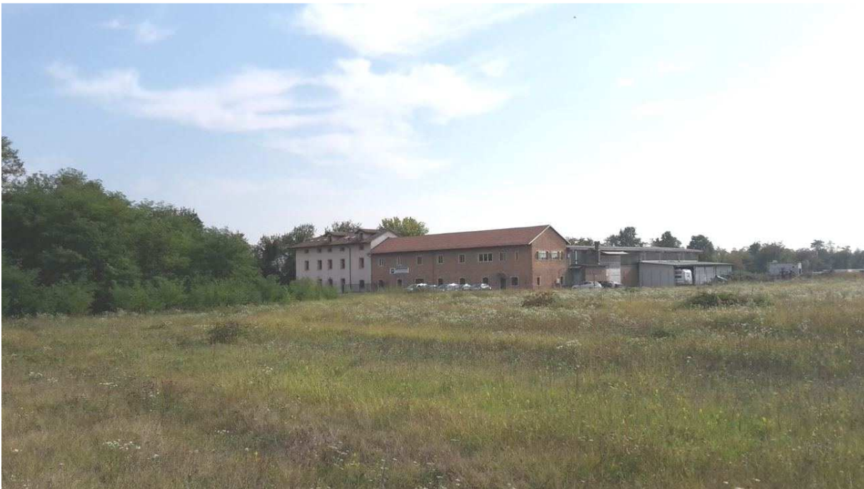
Foto 15: Area di intervento destinata al nuovo impianto di produzione di energia termica ed elettrica mediante combustione di rifiuti speciali non pericolosi; sullo sfondo la cascina destinata alla demolizione ed il confine est dell'area di proprietà che corre lungo la Strada della Mandria
