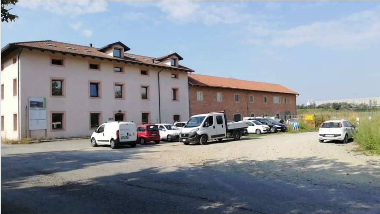
Foto 12: Strada della Mandria, accesso e area parcheggio in prossimità della cascina destinata alla demolizione
