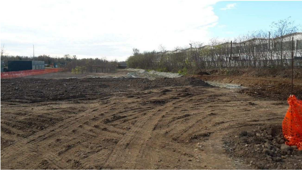
Foto 8: Area di proprietà, visione di insieme confine ovest (sulla destra dell'immagine); lungo il confine ovest dell'area di proprietà sono presenti alcuni fabbricati industriali di proprietà di Terzi. Nell'immagine è visibile anche la recinzione in cemento presente lungo il confine ovest dell'area di proprietà.
