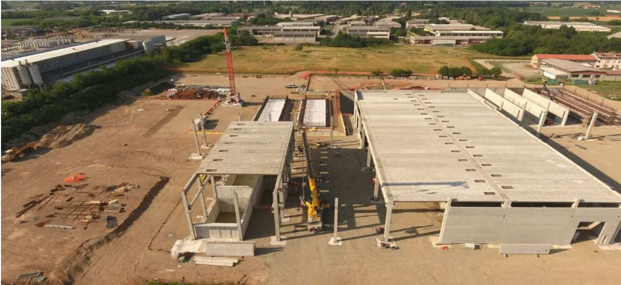
Foto 18: Vista aerea dell'area di cantiere dell'impianto FORSU attualmente in fase di costruzione; sullo sfondo dell'immagine è visibile l'area di intervento destinata al nuovo impianto di produzione di energia termica ed elettrica mediante combustione di rifiuti speciali non pericolosi (attualmente a verde), sulla sinistra dell'immagine è visibile il confine ovest dell'area di proprietà e, oltre la recinzione in cemento, i fabbricati industriali di proprietà di Terzi.
