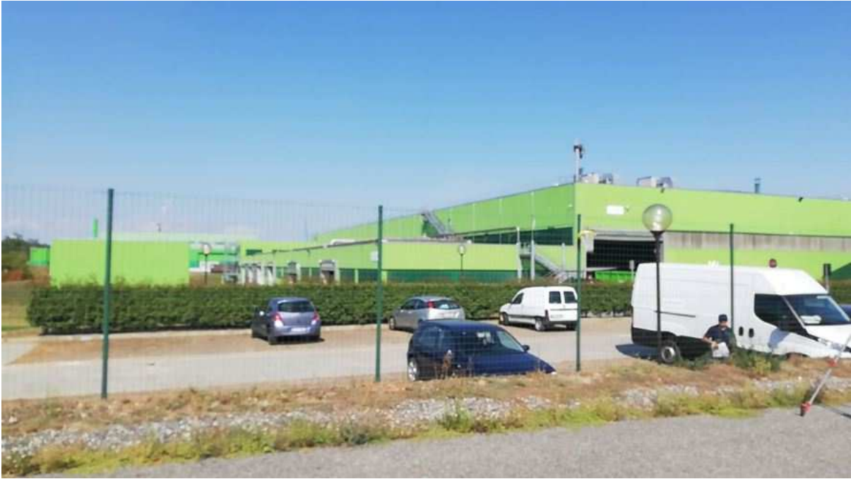
Foto 28: Vista laterale dell'impianto TMB
