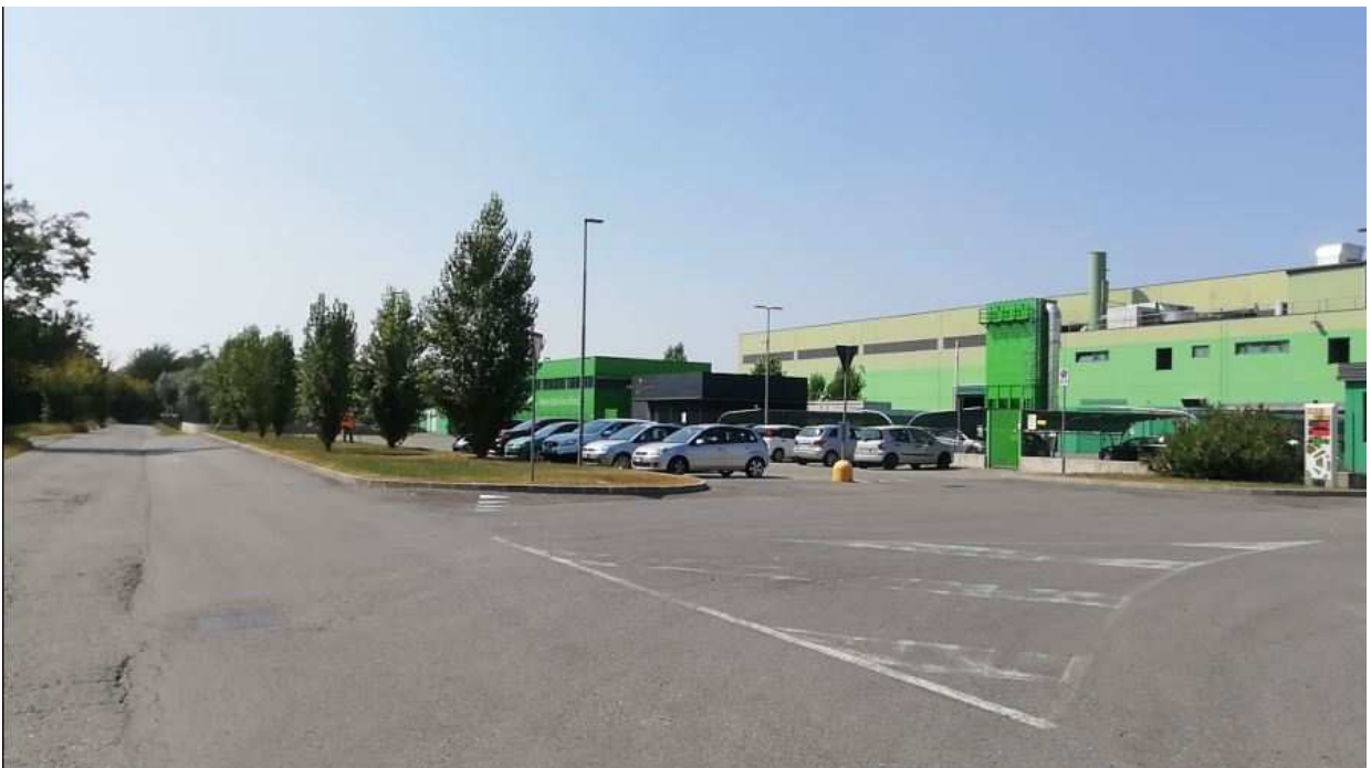
Foto 21: Strada della Mandria, area a verde e parcheggio davanti all'impianto plastiche in prossimità del relativo ingresso
