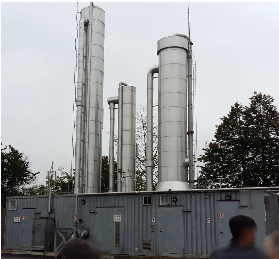
Esempio di impianto di upgrading con torri di assorbimento, flash e desorbimento e container per le apparecchiature
