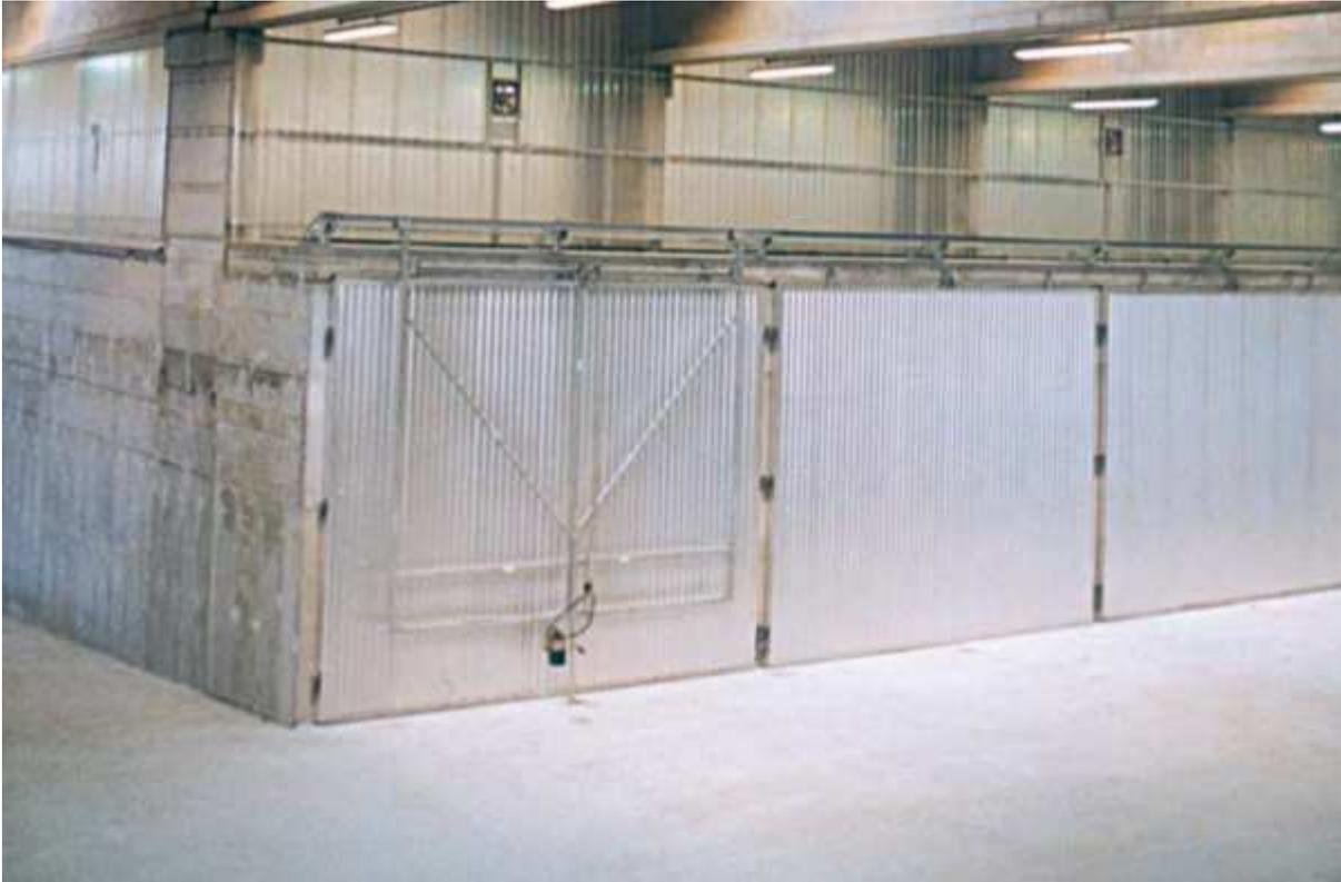
Esempio di biocella aerobica con portoni a tenuta.
