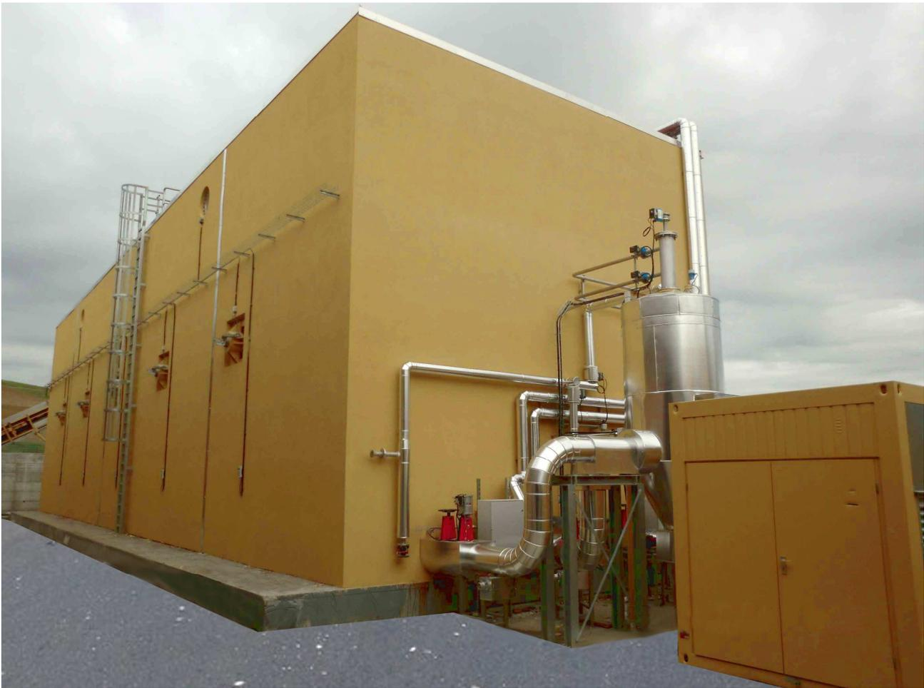
Esempio di digestore plug-flow
