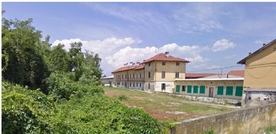
Edificio residenziale in corte, sito sul lato est della ferrovia a nord della via Brianco, al momento del rilievo risulta disabitato.
