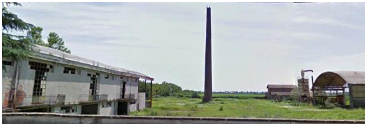
Figura 38 – Stato attuale della Fornace
