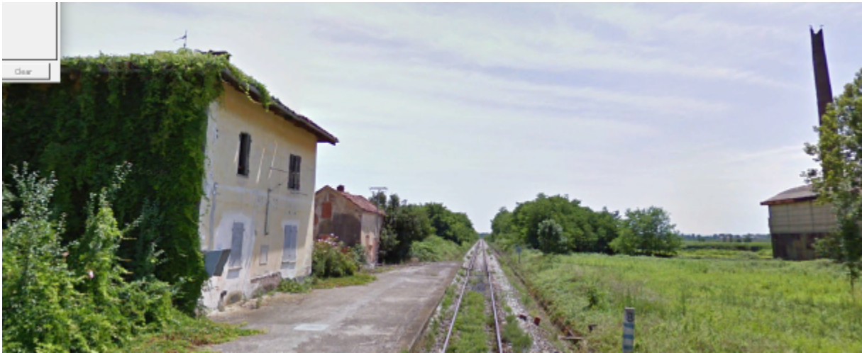
Figura 45 – vista attuale della stazione Brianco
