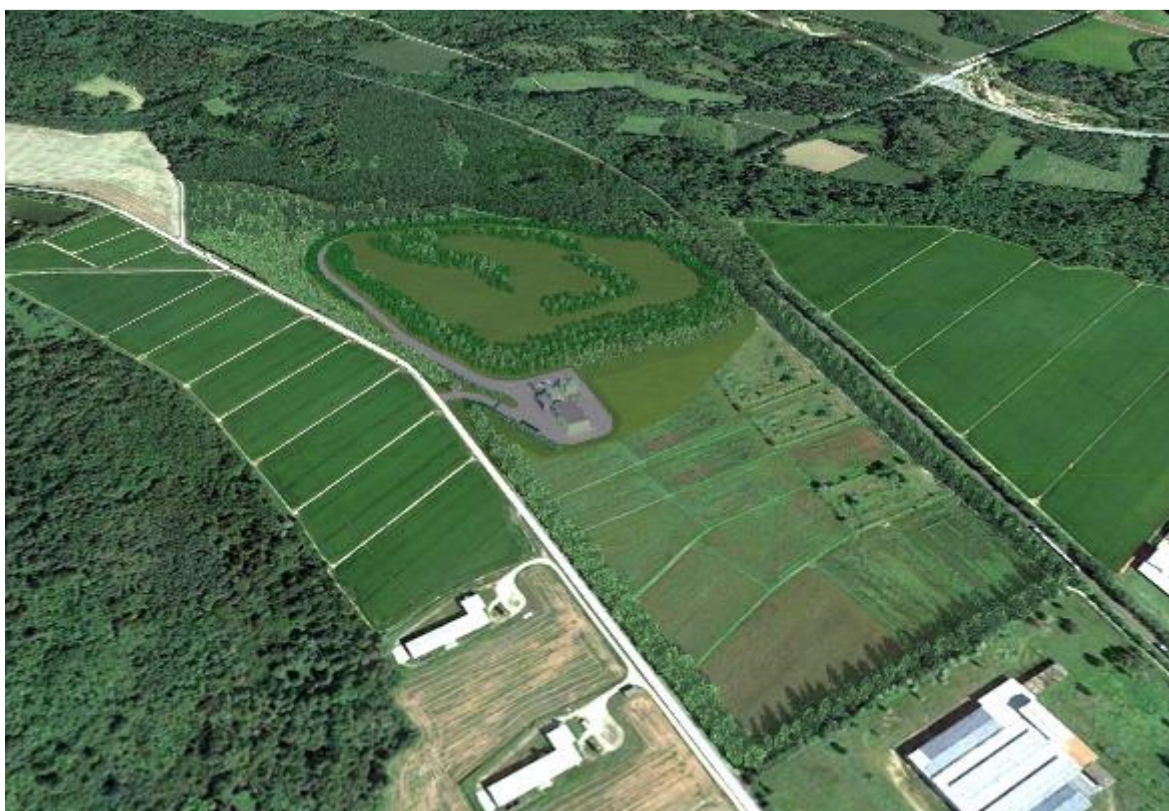
Figura 48 Visuale aerea d’insieme a ripristino effettuato
