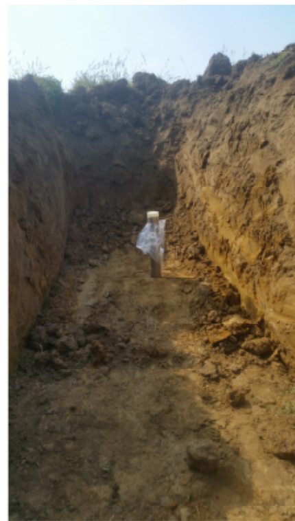
Figura 2: fustella infissa durante la prova a quota più profonda
