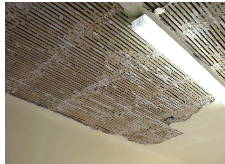
Foto 4 - particolare rimozione parziale intonaco su "canticciato"
