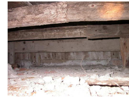
Foto 2 - particolare controsoffitto in CLS
